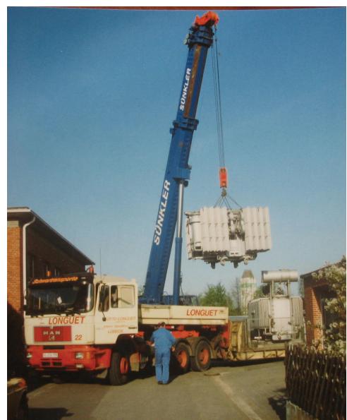
Abb. 27: Abtransport der Umspanner des alten Umspannwerkes
