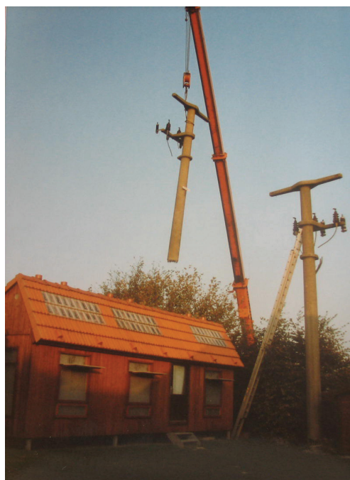
Abb. 23: Abbau des Betonmasts am Taubenhaus, 1992
