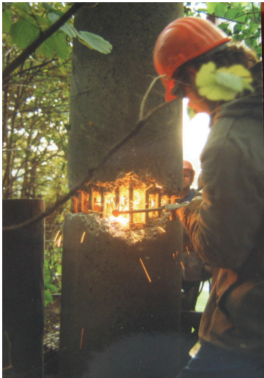
Abb. 24: Abbrennen eines Betonmastes (1992)
