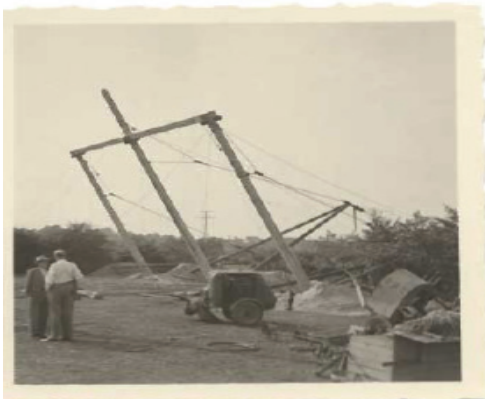
Abb. 13 bis 16: Errichtung eines Beton- Abspannportals
