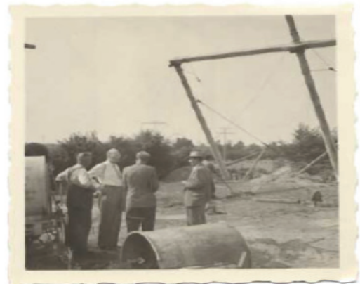
Abb. 13 bis 16: Errichtung eines Beton- Abspannportals
