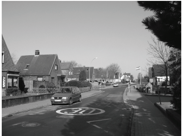
Wilhelm-Stabe-Straße, Richtung Nord, Einmündung Lilienweg/Am Bogen
