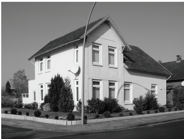
Ecke Diekredder / Wilhelm-Stabe-Straße, Haus 61
