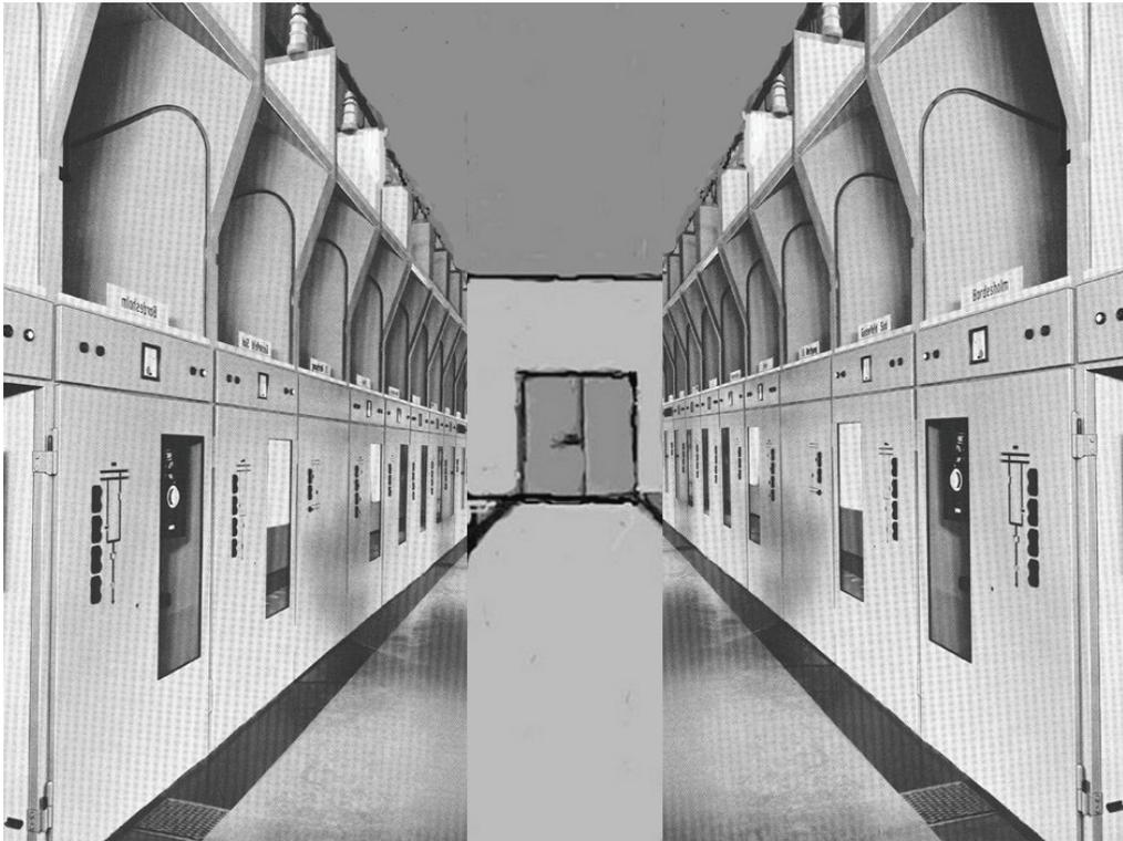
Abb. 16: Etwa so wie in dieser Montage muss man sich den Mittelgang des Schaltheuses vorstellen – es gab zwei Reihen mit je 8 Schaltern<sup>35</sup>
